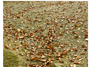
Belagsschäden in Chaussierung durch Erosion
