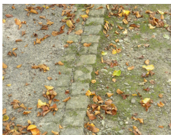
Hebungen/Senkungen im Bereich von Natursteinbelägen
